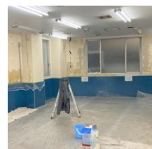
まずは駐輪場から。現場の作業は 5/13（土）までを予定しています。
